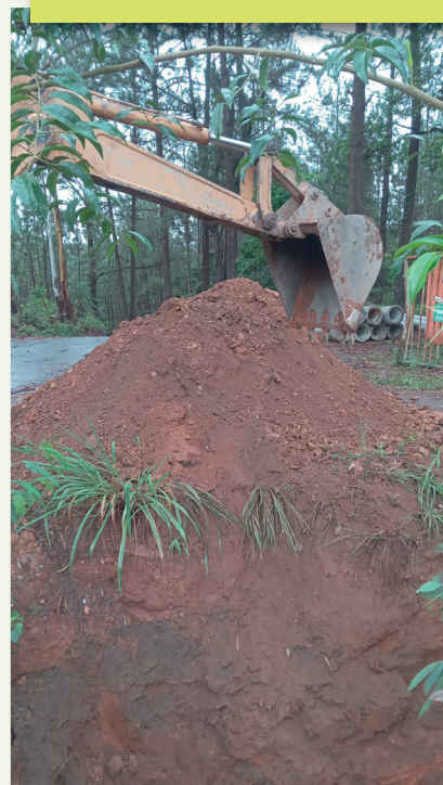
Uma máquina escavadeira foi alugada para fazer a limpeza dos bueiros na estrada, evitando a descida de material para dentro do Residencial
