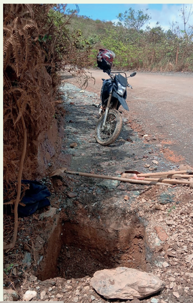
As caixas de passagem na beira da estrada passaram por manutenção e limpeza, de forma a facilitar a descida das águas de chuva
