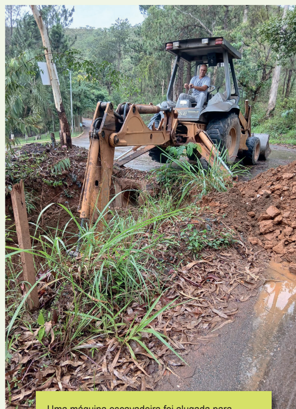
Uma máquina escavadeira foi alugada para fazer a limpeza dos bueiros na estrada, evitando a descida de material para dentro do Residencial
