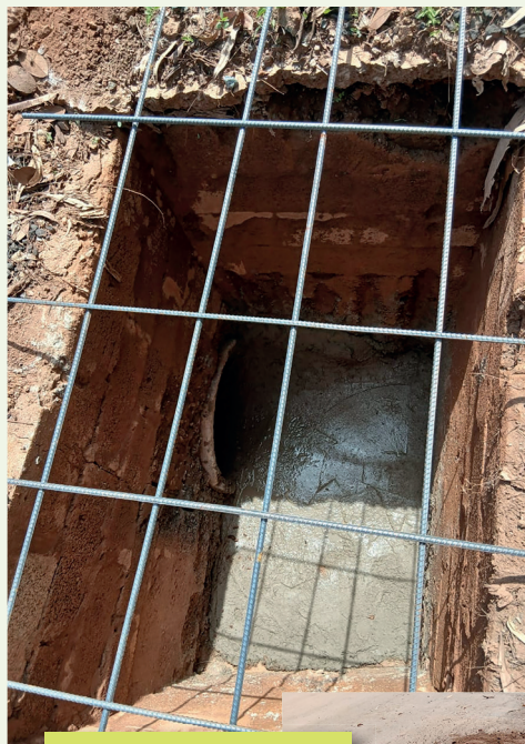
As caixas foram dotadas de uma tampa feita com ferragens e concreto para evitar entrada de materiais que seriam enviados para dentro do condomínio
