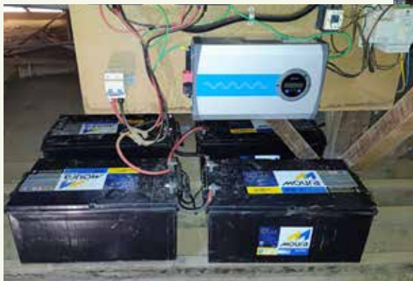
As novas baterias e as placas que fornecem energia para os equipamentos da portaria
