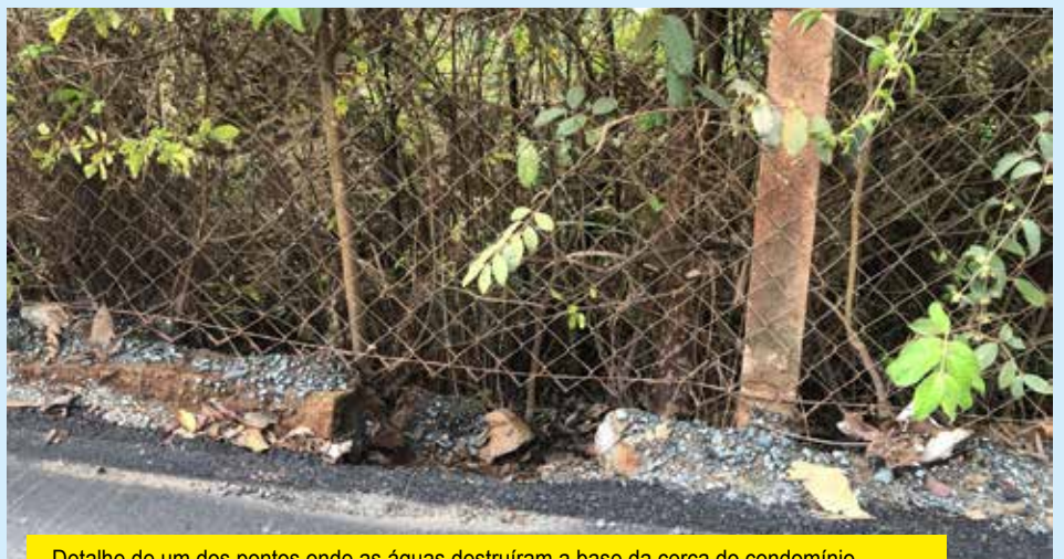
Detalhe de um dos pontos onde as águas destruíram a base da cerca do condomínio
