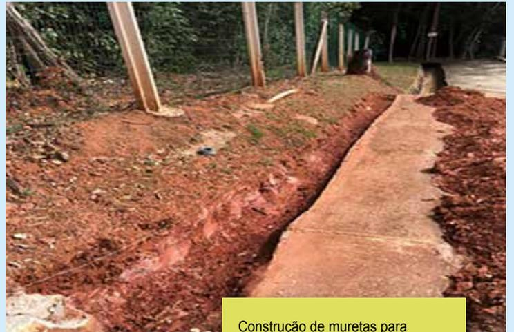
Construção de muretas para proteção e limpeza de pisos e rampas em épocas de chuva, pois neste período, as águas são escoadas dos taludes, sujando de barro os pisos da rampa de entrada e dos quiosques
