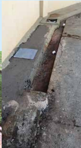
Instalação de nova caixa de gordura e revisão da tubulação esgoto
