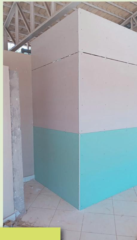
O fechamento e reposicionamento das paredes foram executados em Drywall, com uma estrutura metálica, para posteriormente receber a pintura
