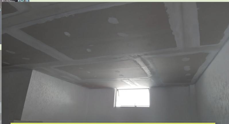
O fechamento do teto foi executado em gesso e totalmente emassado para receber a pintura e uma nova iluminação
