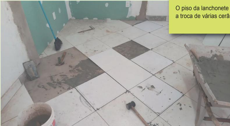
O piso da lanchonete recebeu manutenção, com a troca de várias cerâmicas e novos rejuntas
