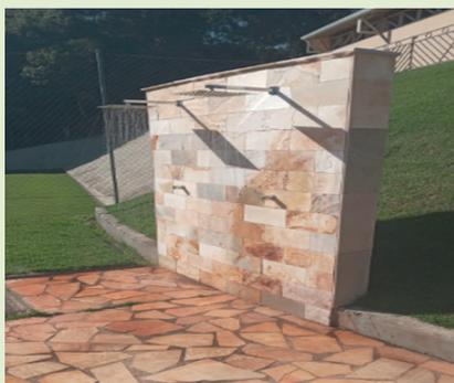
Substituição do antigo chuveiro por duas duchas modernas, com grande vazão de água, instaladas em parede de alvenaria com acabamento em pedras São Tomé. A obra foi executada em função da precariedade da instalação anterior com manutenção e vazamentos recorrentes.
