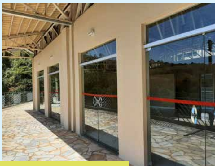
O piso em torno da área de convivência foi todo lavado e as paredes reformadas, ganhando nova pintura
