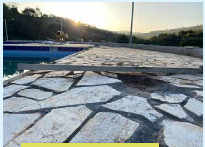
Piso de pedras já está sendo preparado ser rejuntado
