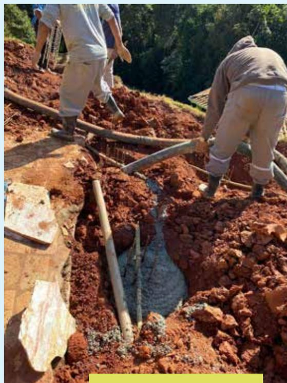
O serviço de concretagem foi feito com bombas de sucção que retirou o concreto da betoneira para preencher os tubulões
