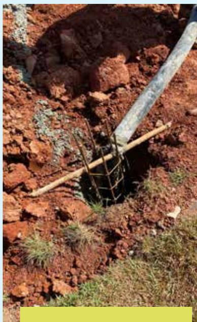
A ferragem foi armada e colocada nos tubulões furados na terra natural
