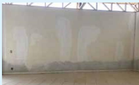
Todas as bases das paredes que estavam danificadas foram recompostas com a utilização de produtos apropriados para que sejam restauradas de forma a proteger e evitar novas infiltrações para, assim, receber uma nova pintura.
