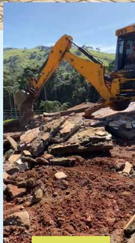
Os blocos do piso que foram retirados precisaram ser quebrados pela máquina para facilitar a remoção e, posteriormente, serem colocados em caminhões para a retirada de todo o entulho gerado
