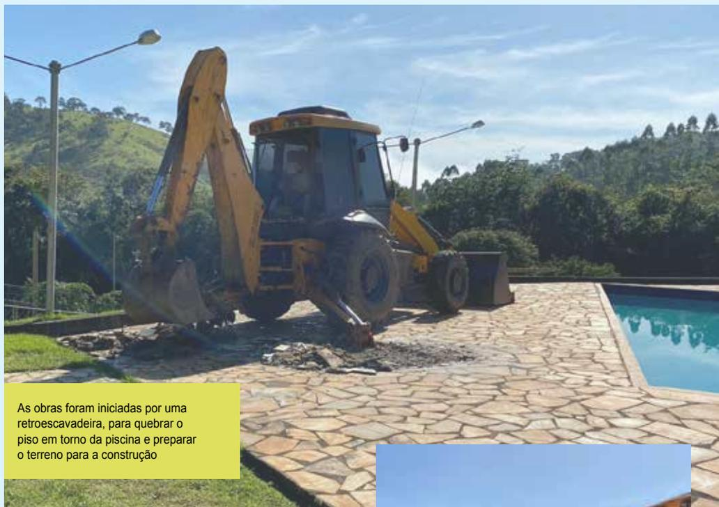
As obras foram iniciadas por uma retroescavadeira, para quebrar o piso em torno da piscina e preparar o terreno para a construção
