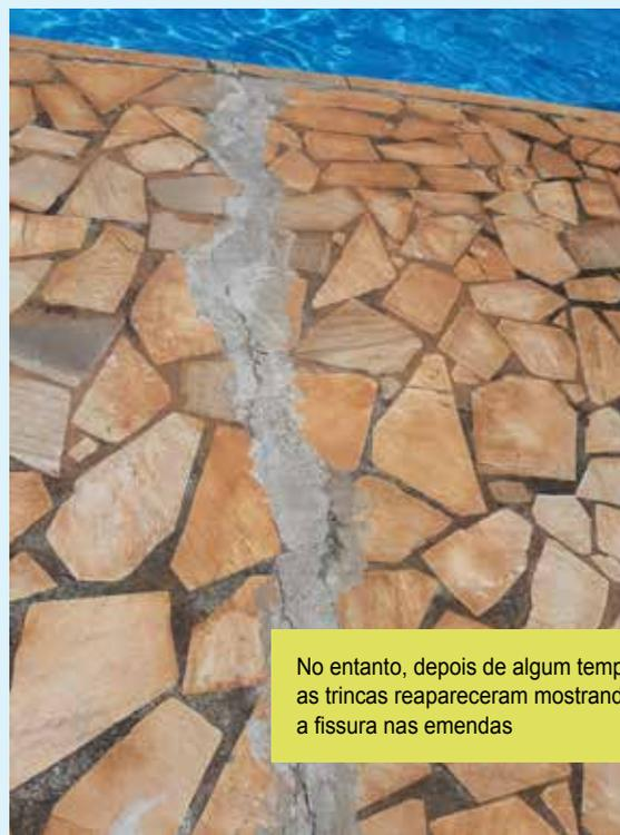
No entanto, depois de algum tempo as trincas reapareceram mostrando a fissura nas emendas
