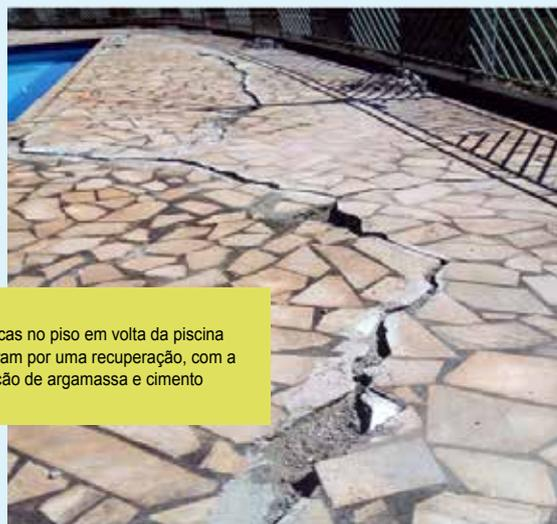
As trincas no piso em volta da piscina passaram por uma recuperação, com a aplicação de argamassa e cimento
