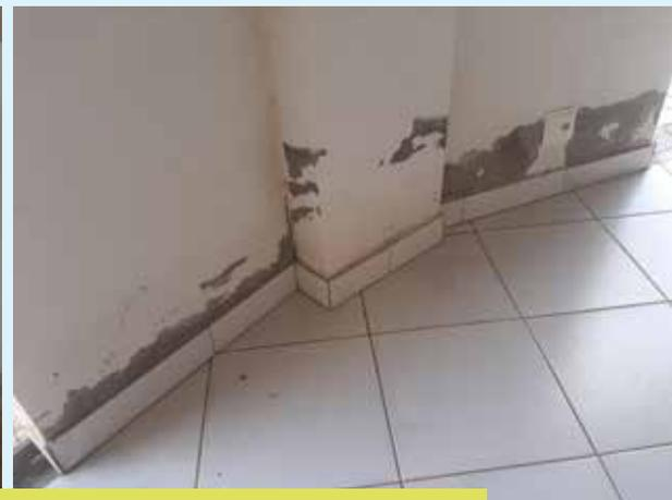
Internamente a alvenaria do clube apresenta infiltrações em todos os ambientes, que são consequências da umidade no solo pelo volume de água que se acumula nos pisos e estão danificando as bases das paredes, dificultando a limpeza e interferindo no aspecto visual
