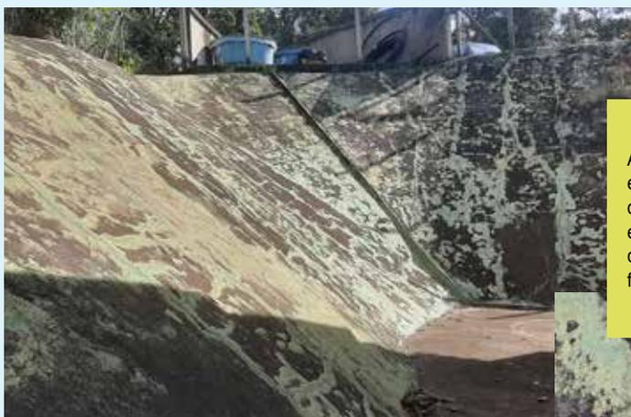
Atualmente os taludes estão completamente danificados, com trincas e rachaduras que podem comprometer suas funções de contenção
