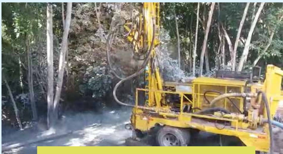
O equipamento de perfuração trabalhou intensamente durante 20 dias
