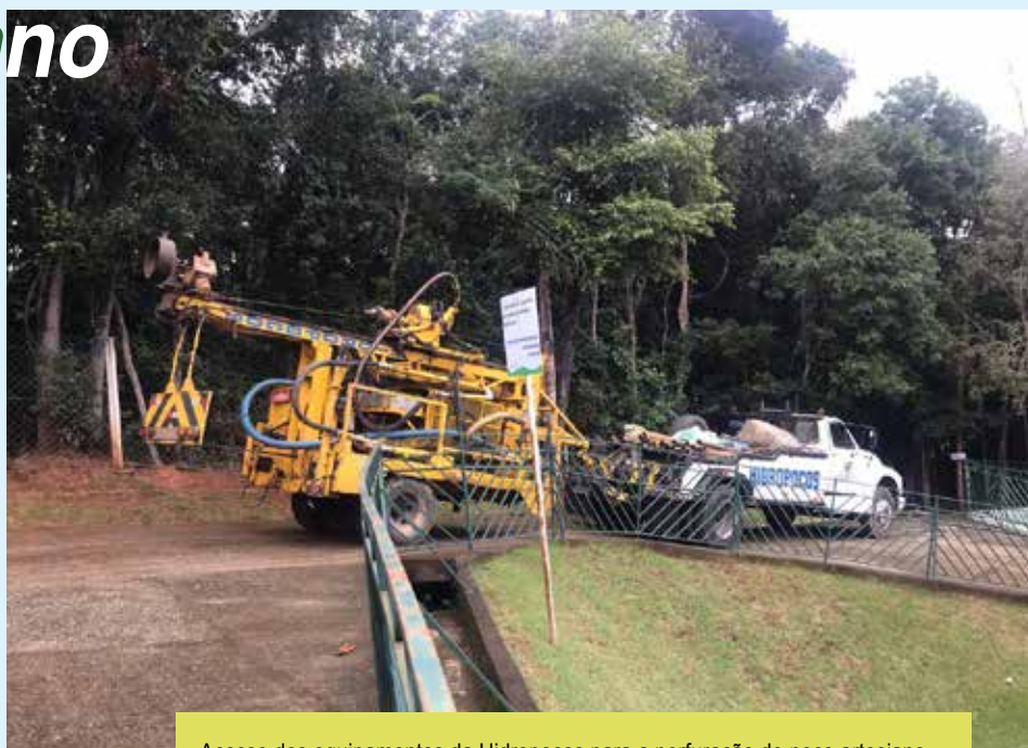
Acesso dos equipamentos da Hidropoços para a perfuração do poço artesiano
