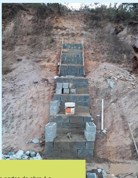
Uma das partes da obra é a construção de uma escada dissipadora ao longo do talude, com concreto armado e blocos de cimento, para suportar a força das águas
