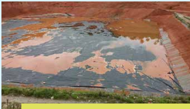
Barragem Mina Engenho da mineradora Mundo S.A. em Rio Acima, fotografada por Vera Amaral na visita técnica do Codema.
