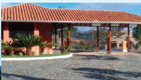
A fachada passou por uma renovação total e a guarita teve nova pintura, calhas reformadas e cancelas automatizadas para entrada
